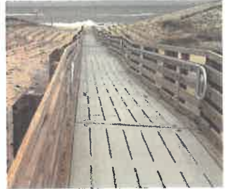
ADA accessible ramp - Cape Hatteras
